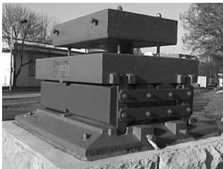
Originallager der Friedrich-Ebert-Brücke Magdeburg (heutige Sternbrücke): Einbauzeit 1918-2000, Rekonstruktion 2000, Verstellbereich 12 cm, Eigengewicht 6,8 t
