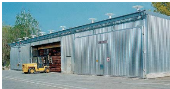
Bild 9-1 In Reihe gebaute Trockenkammern mit Beschickung durch Frontstapler und Hebeschiebetor (Bild: EISENMANN)
