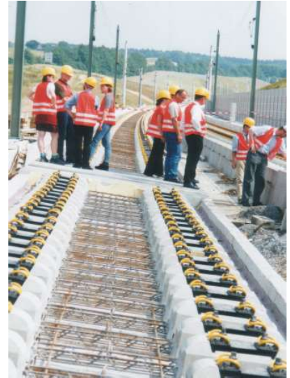
Bild 2.5 Überhöhung im Kreisbogen (im Bau)
