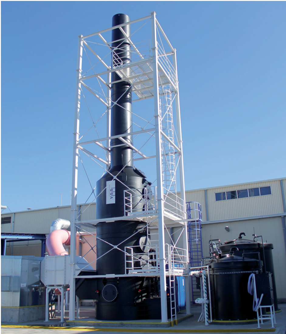
Bild 4.23 Vertikaler Abluftwäscher Durchmesser 2,8 m mit einer Leistung von 60 000 Nm 3 /h, Werksbild Fa. VSS-Umwelt- technik GmbH, Troisdorf
