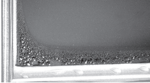
Bild 1.8: Tauwasser und mehrdimensionales Temperaturfeld an einer Verglasung.
