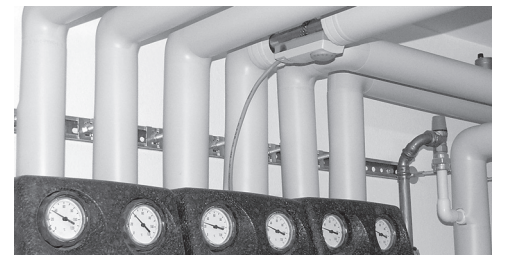
Bild 1.7: Gedämmte Rohrleitungen.
