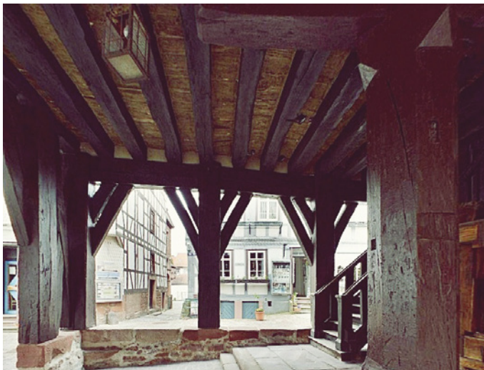
Bild 2.4 Blick in die Vorhalle des Rathauses
