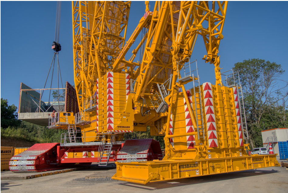
Bild 1.10 Ein Liebherr LR 11000 beim Einhub eines 200 Tonnen schweren Betonfundaments auf einer Bahnbaustelle bei Affalterbach 2020. Durch Gegenausleger und circa 300 Tonnen Gegengewicht kann der Ausleger diese Last auf bis zu 40 Meter Radius transportieren, ein Lastmoment, das mit einem Mobilkran undenkbar wäre. Man erkennt auch gut den Nachteil dieser Krankategorie: im Gegensatz zu Kranen mit Rädern sind Raupenkranen nicht sehr mobil; ein LR 11000 braucht je nach Konfiguration 40 bis 60 Schwertransporte und eine Woche Zeit zum Aufbau.
