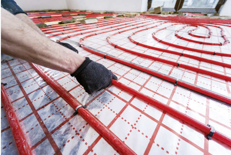
Bild 1.3 50 Jahre haltbare, korrosionsbeständige, leichte und leicht zu verlegende Rohre einer Fußbodenheizung aus vernetztem Polyethylen mittlerer Dichte (PE-MD) mit Sauerstoffbarriere aus Ethylen-Vinylalkohol Kunststoff (EVOH) (iStock.com/romaset)
