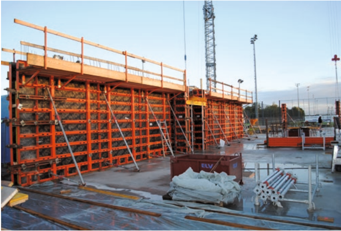
Bild 5.4 Rahmenschalung für Wände, Bildquelle: PASCHAL
