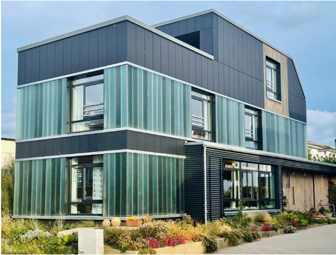
Bild 1.1 Nachhaltiges Bauwerk in Hannover
