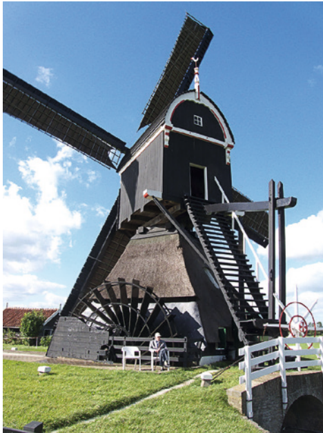
Bild 1.5 Wippmühle (Kokerwindrad) mit Schöpfrad (© Wikipedia, User: Rasbak)
